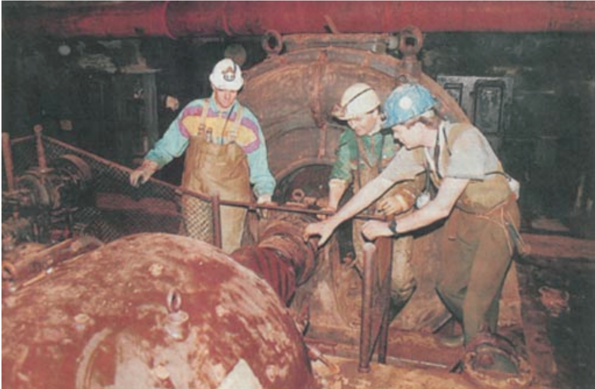
Foto: Inspektion der Untertage-Anlagen des Kavernenkraftwerkes im Drei-Brüder-Schacht.
